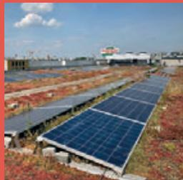
📷 Während ihr unten schwitzt, erzeugt die Sonne auf dem Dach der ASH Berlin jährlich 81.000 kWh grünen Strom! Mit Hilfe der Berliner Stadtwerke befinden sich dort seit dem Jahr 2020 346 #Solarmodule und sparen der Stadt #Berlin so rechnerisch 40 Tonnen #CO2-# pro Jahr ein.
